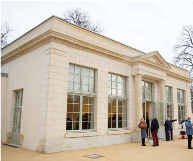
Ce bâtiment va permettre d'accueillir des expositions, des réceptions et des événements en rapport avec la grandeur de l'édifice.
