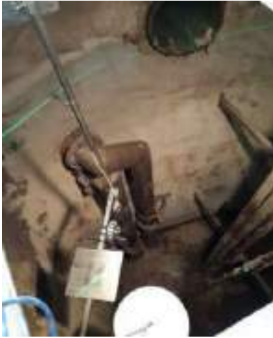
Mire d'étalonnage positionnée avec un laser Trop-plein des Granges Galand St Avertin
