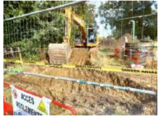
(pelle mécanique pour le ramassage des déchets)
