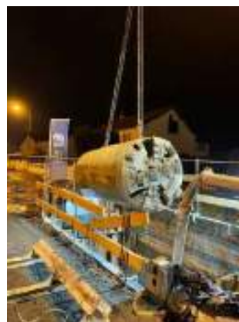
Retrait du micro-tunnelier
