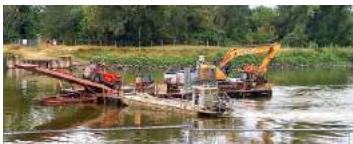
(amenée du matériel par voie fluviale)
