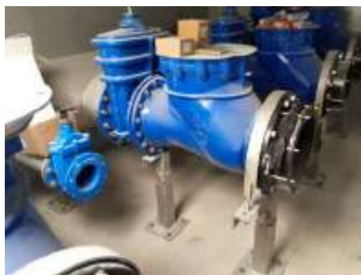
Pose de vannes au poste Sud
