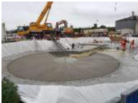
Travaux de la bache à boues
