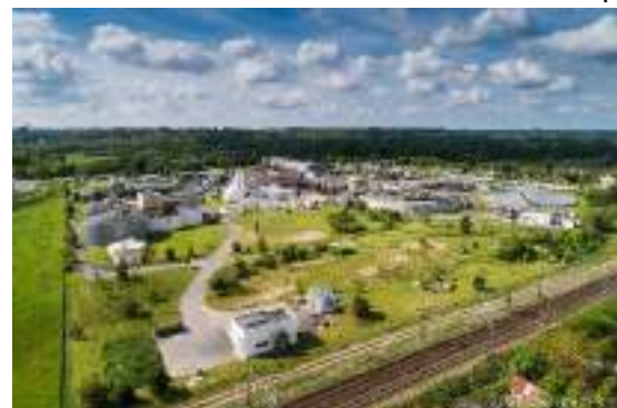
Photo aérienne de la STEP de la Grange David à La Riche
