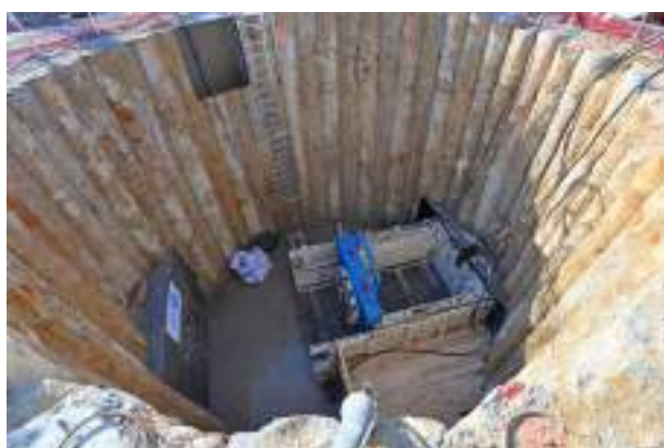
Puits pour le forage en micro-tunnelier rue de Suède
