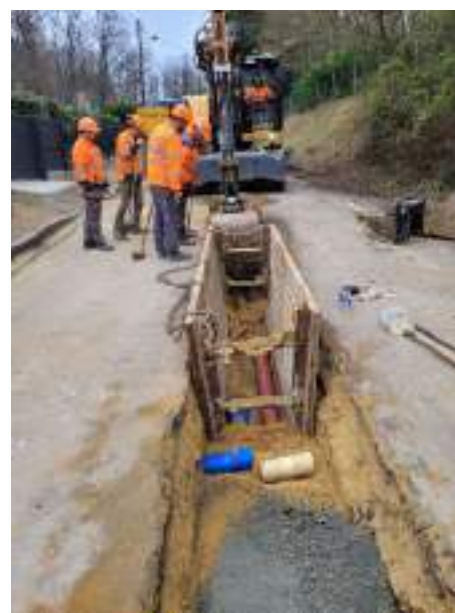
Travaux sur réseaux à Parçay-Meslay
