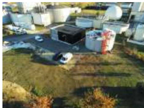
Travaux local pompe à chaleur
